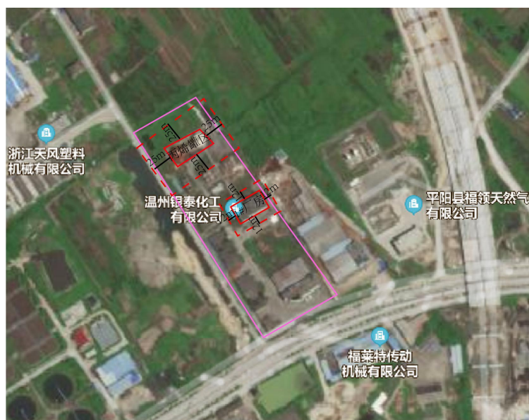
图 5-10 温州银泰化工有限公司丙烯罐区和 1#厂房安全距离 (5) 嘉利达（平阳）明胶有限公司
